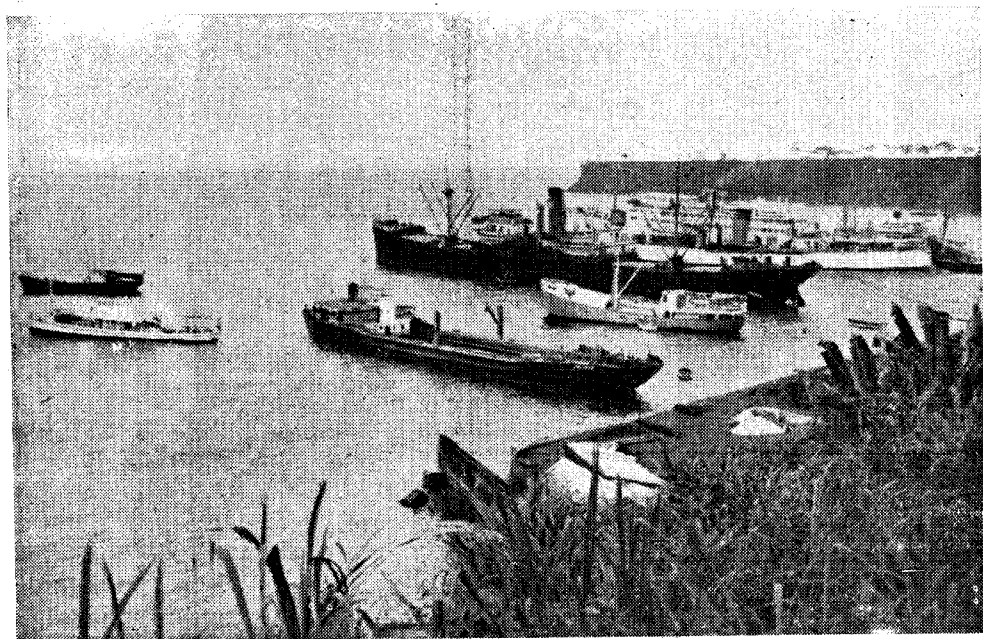
Diversos aspectos del puerto de Sta. Isabel
