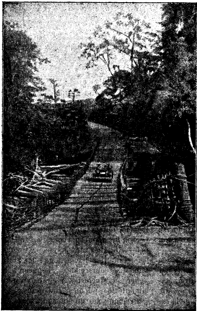
Guinea C. Española.— Primitivo puente en el interior de la selva.
