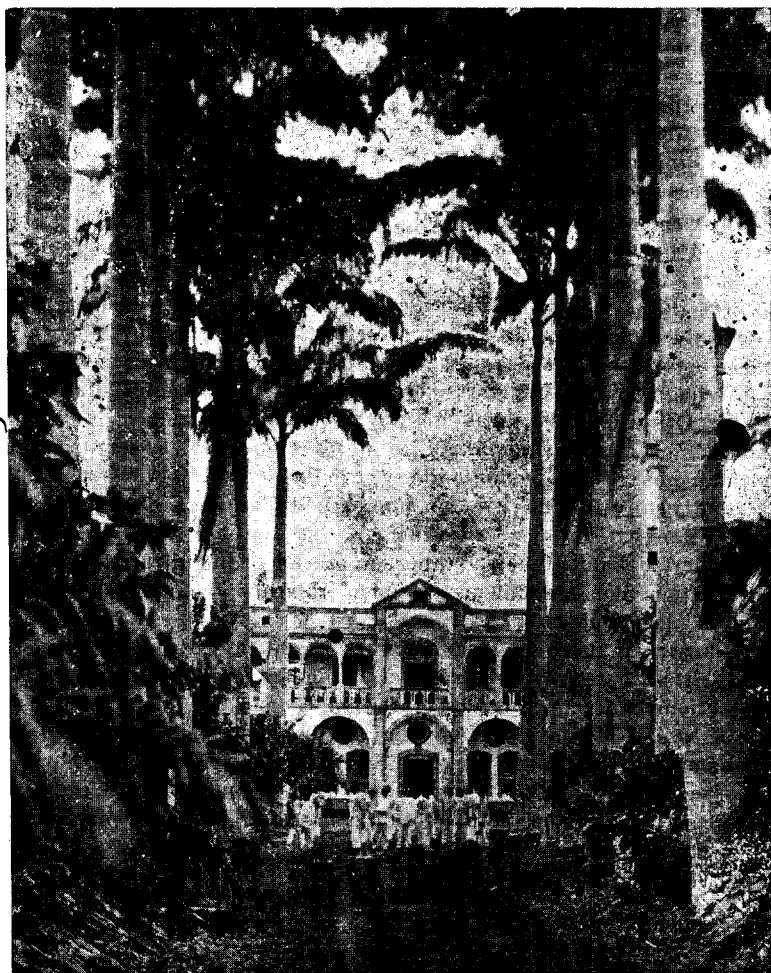
El Seminario de Banapá antes de las grandes reformas realizadas en el edificio.
