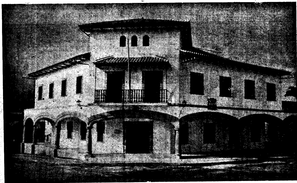
El edificio de la Caja Colonial de Seguros inaugurado en Santa Isabel.
