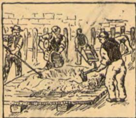
La argamasa o mortero sirve para unir las piedras con que se hacen las paredes, los muros y los tabiques.
