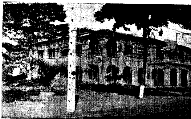
Bata. Edificio del Subgo- bierno, en construcción.
