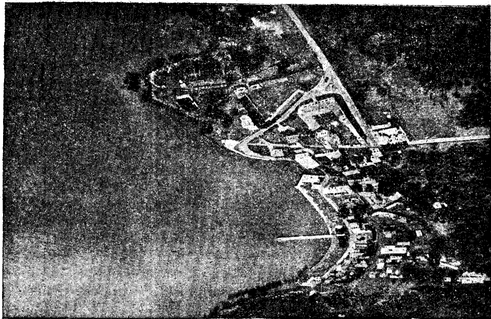
Vista aérea de la ciudad de S. Carlos, con su espigón.
